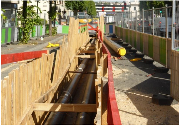
Figure 12. Pose des conduits des réseaux de chaleur sur sablon, à Arcueil (photo F. Audubert).
