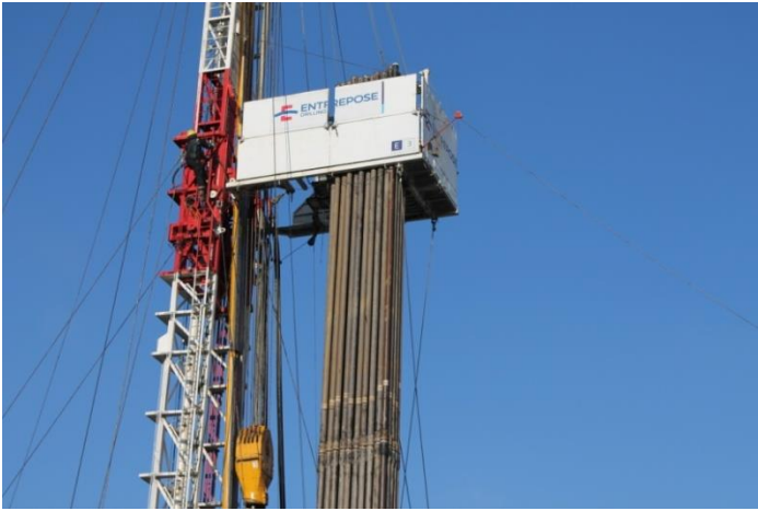
Figure 10. Le mât de forage et la réserve de tubes (photo : mairie de Ris-Orangis).
