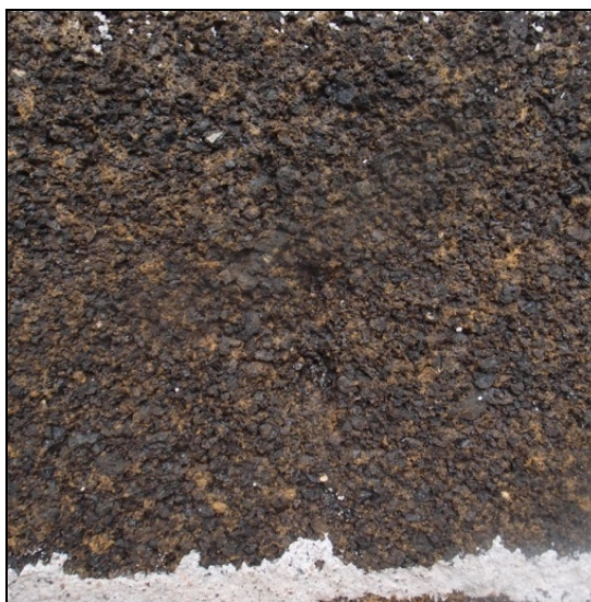
Figure 8. Gros plan sur le tuf de la carrière des Moines (voûte de la nef).
