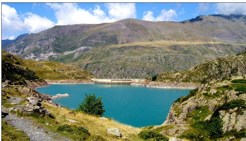
Figure 15. Retenue du barrage des Gloriettes, « suspendue » à 250 mètres au-dessus du gave d'Héas. L'assise à gauche du barrage est faite de hornblendite noire massive ; c'est la bordure du petit massif de gabbro . Les migmatites sont présentes partout ailleurs sur les berges du lac. Au fond, c'est-à-dire en rive droite du gave de Héas, les flancs abrupts de la vallée ont été taillés par le glacier dans le socle de gneiss, et on discerne bien la limite supérieure de ce dernier, correspondant à l'accident majeur de chevauchement par les terrains paléozoïques de la nappe de Gavarnie.
